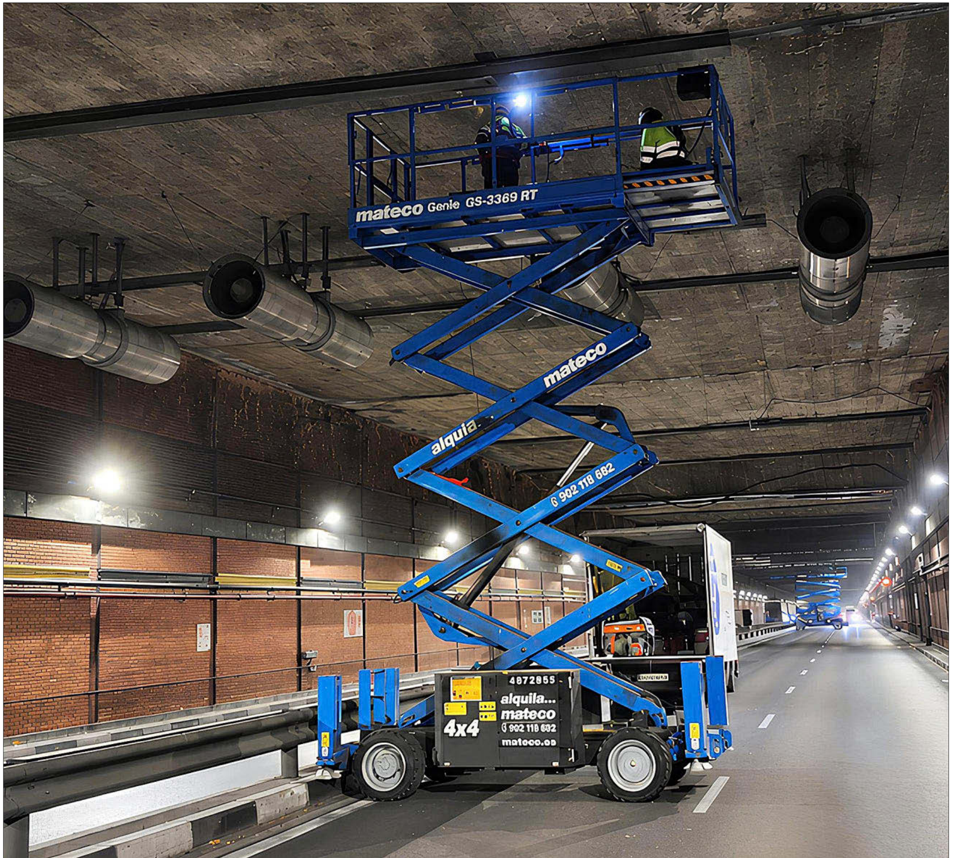
Operarios trabajan en el mantenimiento y renovación del túnel de Gran Vía de Hortaleza, de 555 metros, situado entre la calle Costa Rica y la zona de Pinar del Rey. E. M.
