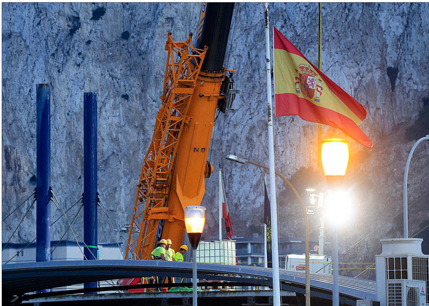
Tareas de retirada de marquesina y estructuras en la parte española de la verja de Gibraltar. A. CARRASCO / EFE
