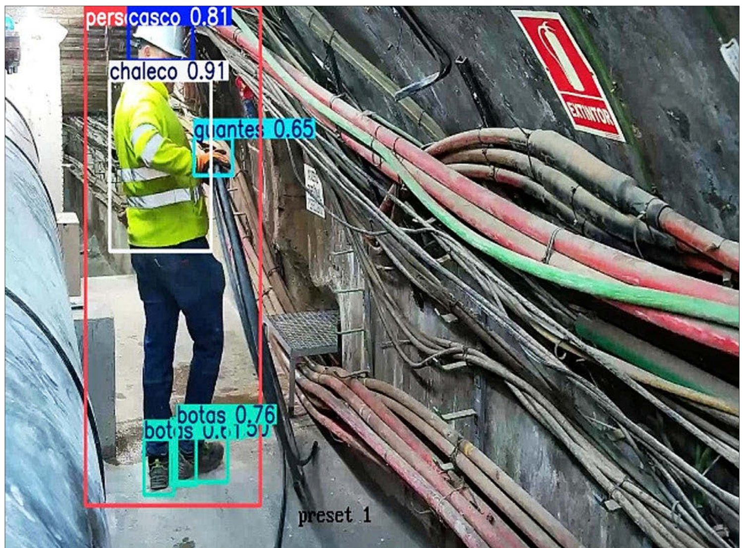
Operarios trabajan en una de las galerías subterráneas, mientras la IA identifica que el protocolo de seguridad sea el correcto. E. M.
